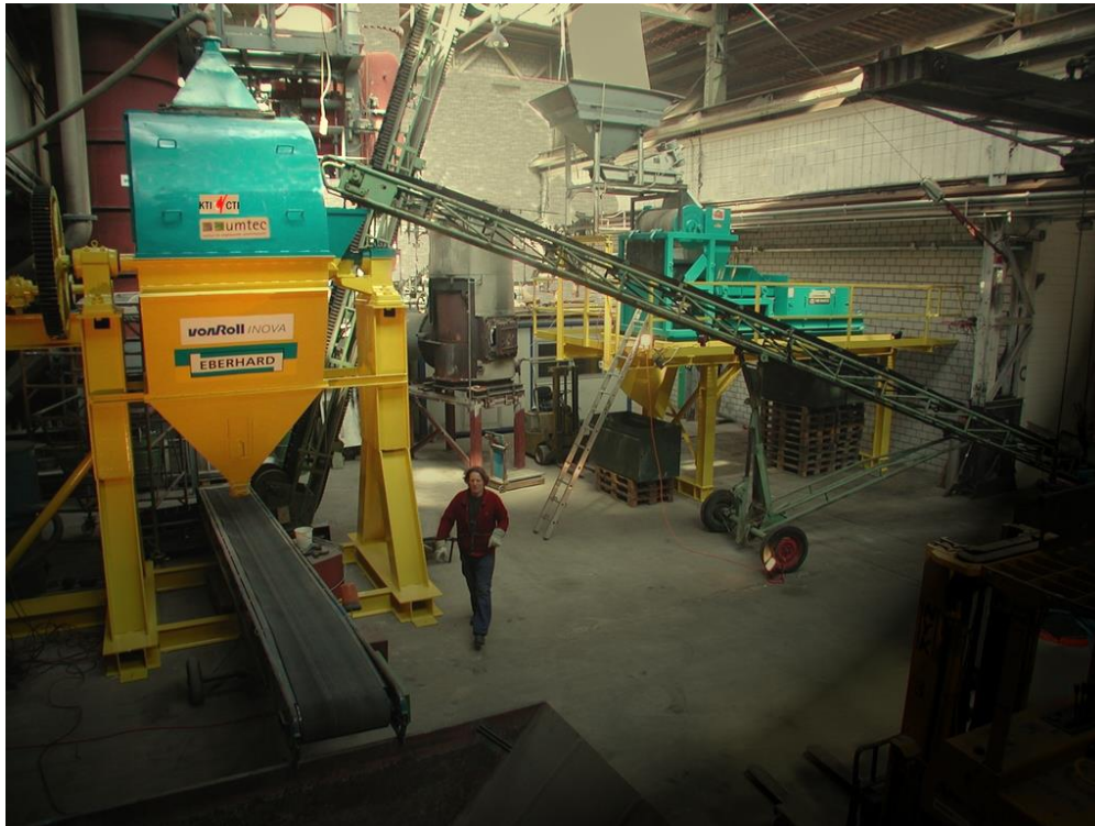
Abbildung 2 Schlackemahlung in einer Kugelmühle im Versuchszentrum Klus (Mahlraumabmessungen: Breite 1240mm, Durchmesser 1720 mm, Gewicht Mahlkugel: 5.5 kg, Gesamtmasse Kugeln ca. 1 Tonne)
